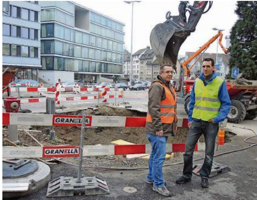
Christian Wolff von der Abteilung Tiefbau (links) und Projektleiter Urs Grimm stehen vor dem Schacht in der Einfahrt zur Zürcherstrasse.
