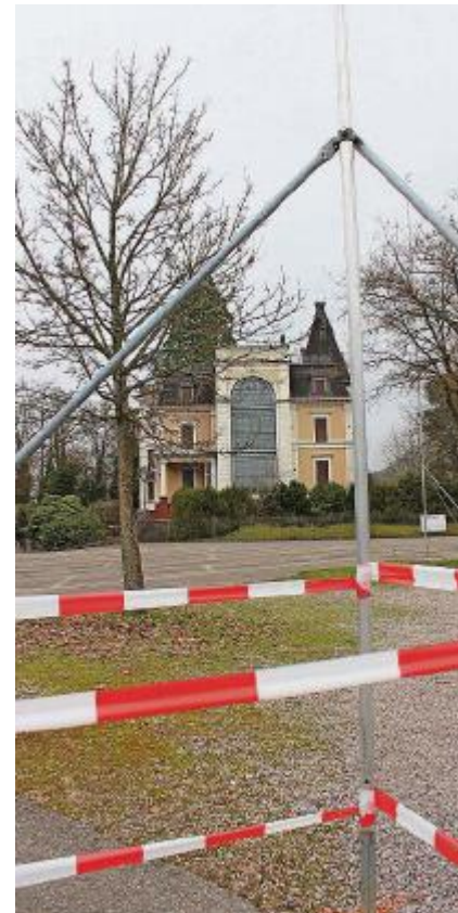
Bauprofile für Überbauung beim Schloss Bad Zurzach stehen.
