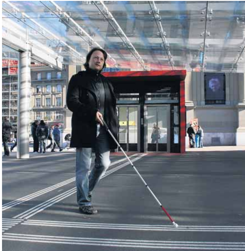
Die taktilen Leitlinien helfen Blinden und Sehbehinderten bei der Orientierung Bild: zVg
